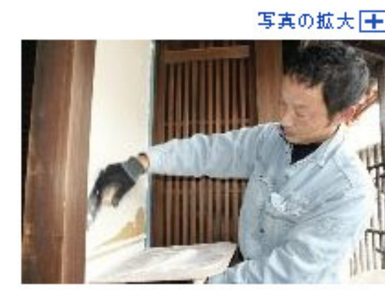
慣れた手つきで漆喰を伸ばす宮奥淳司さん。日本建築の良さを発信する(宇陀市で)
